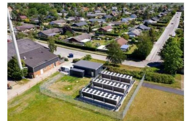
Abb. 15: Beispiel einer 1 MW Luftwärmepumpe
